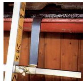
An der Leiter befestigter Sicherheitsbügel
